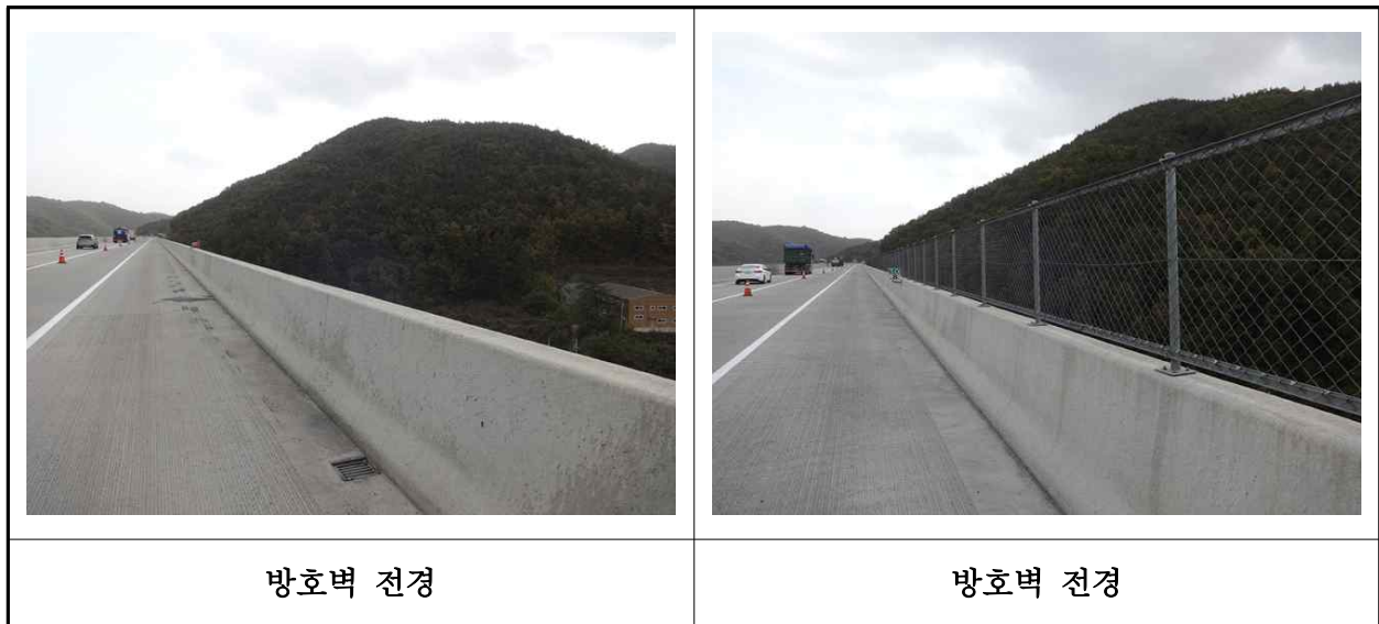
【사진 10.3.46】 방호벽 및 중앙분리대 전경
