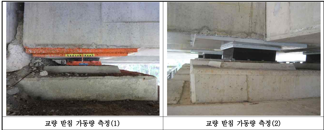
【사진 10.3.38】 교량받침 이동량 측정
