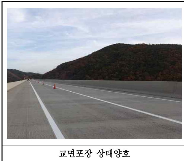
【사진 10.3.20】 교면포장 손상현황
