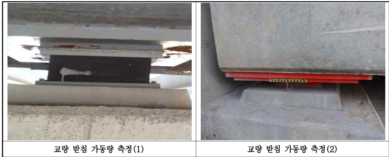
【사진 10.3.15】 교량받침 이동량 측정
