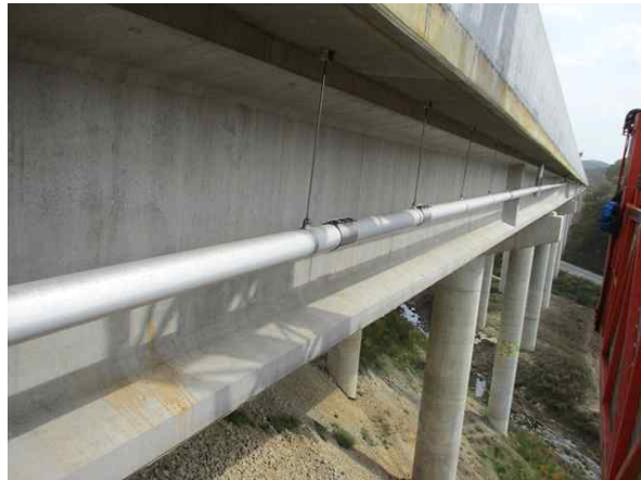
배수시설 상태 양호
