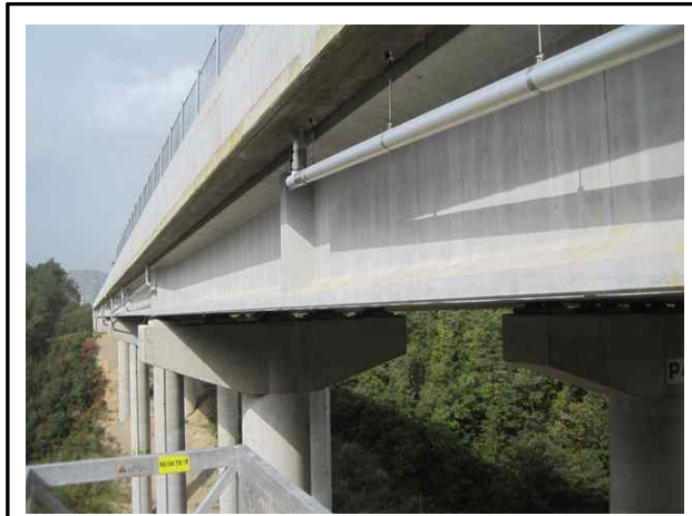
거더 내측 전경
