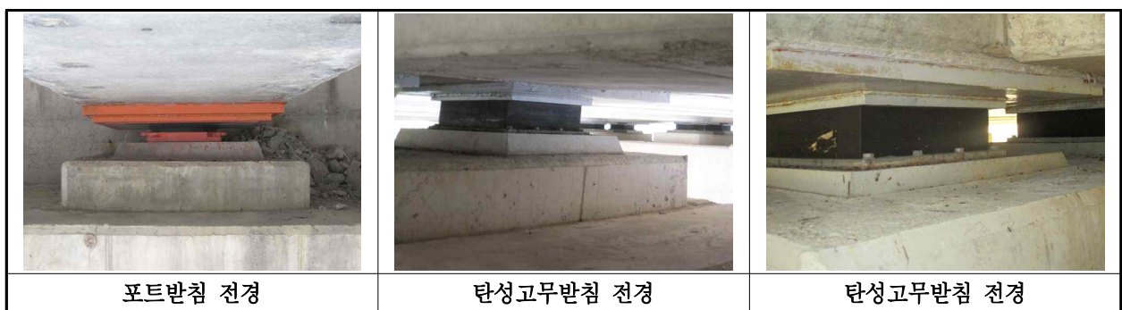
【사진 10.3.35】 교량받침 전경
