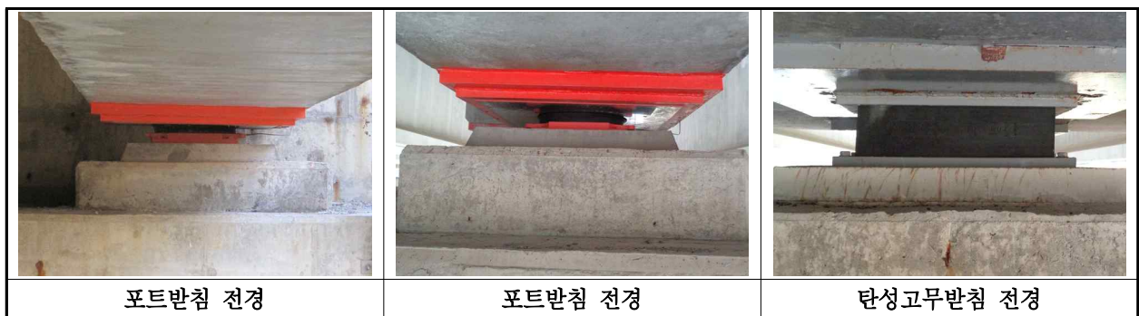
【사진 10.3.12】 교량받침 전경
