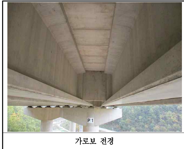
【사진 10.3.29】 가로보 전경
