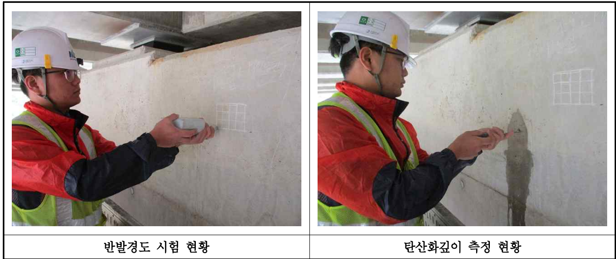
【사진 10.4.1】 콘크리트 내구성조사 현황
